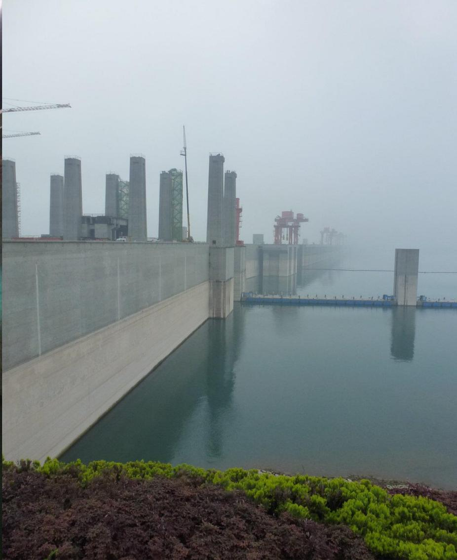
In fünf Schleusen-Stufen des Drei-Schluchten-Dammes werden wir mit unserem Schiff 175 m tief auf das Niveau des Yangtze hinter dem Stauwehr abgesenkt. Diese nächtliche Prozedur dauert Stunden und den Seeleuten wird dabei ein äußerst präzises Einfahren in die Schleusen abverlangt.
